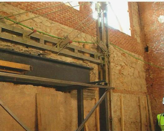
Arriba, imágenes de la ejecución del cargadero que permite la apertura del gran hueco corrido en el muro existente. El peso se transmite a los apoyos de los extremos y al machón central, que hubo de reforzarse insertando una armadura de acero. Para sujetar el muro se montó un apeo de estructura de acero, previa a la inserción del perfil metálico del cargadero.
