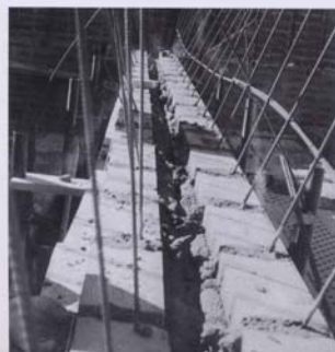
SALA MULTIPLE VIGAS LUCERNARIO DE CERAMICA ARMADA
