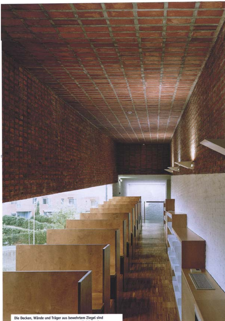
Die Decken, Wände und Träger aus bewehrtem Ziegel sind
